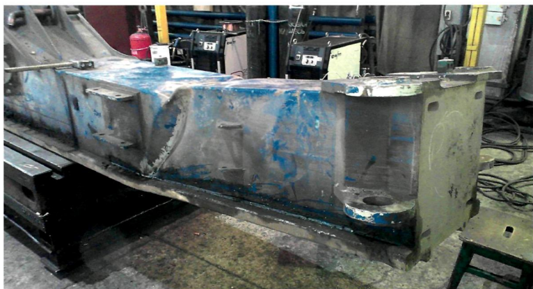
РЕМОНТ СТРЕЛЫ БУРОВОЙ УСТАНОВКИ
