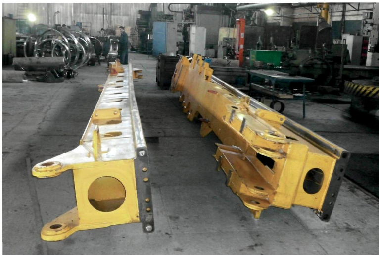
РЕМОНТ СТРЕЛЫ БУРОВОЙ УСТАНОВКИ
