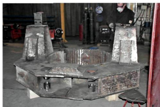
РЕМОНТ ОБСАДНЫХ СТОЛОВ
